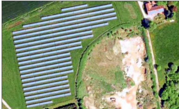
Die 36 000 Quadratmeter große Photovoltaik-Freiflächenanlage in Hasleit erwirtschaftet Strom für rund 350 Haushalte. – Foto: Luftbild Bayern Atlas
